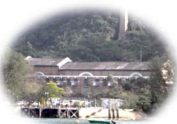
紅磚式建築的泵房，分別設有裝設水泵的大堂、窩爐房、辦公室及煤炭儲存間等。建築物斜尖屋頂以中式瓦片鋪砌而成，木梁由鐵鑄金字構架承托，過去百多年未有任何重大改動。泵站一直沿用至今，現時為水務署轄下歷史最悠久的泵站。
