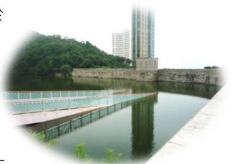
黃泥涌水塘是本港現存第三個最古老的水務建築，水塘在 1899 年落成，成為大潭水塘群以外的輔助水源，進一步增加了港島的儲水設施。弧形水壩高 50 呎、長 270 呎，建於黃泥涌山谷出口處，新水塘的儲水量為 2,700 萬加侖，約為薄扶林水塘儲水量的百分之三十八，成為大潭水塘外的輔助水源。
